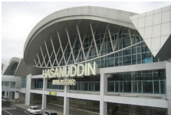
Gambar 8. Sultan Hasanuddin Internasional Airport Makassar
