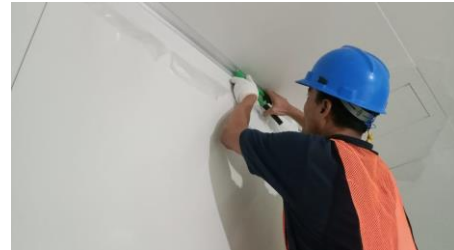
(b) Proses Pemasangan Extrusion
