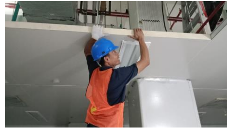
(a) Proses Pemasangan Plafond
