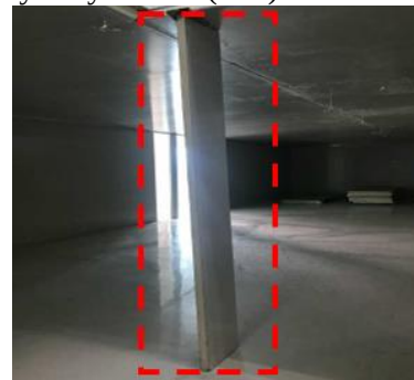
(a) Perkuatan Temporary
