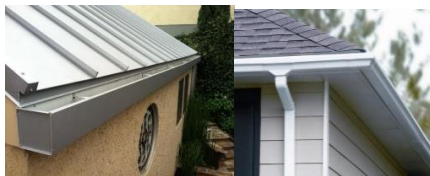
Gambar 5. Talang air PVC bentuk persegi (Sumber : google.com)
