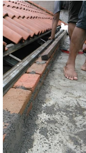
Gambar 1. Pengecekan dan penyetelan sudut genteng di atas talang beton (Sumber : Dokumen Pribadi, 2022)
