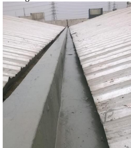
Gambar 6. Talang air Beton (Sumber : google.com)
