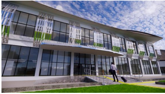
Gambar 22. Bangunan Utama (Sumber: Analisis Penulis, 2023)
