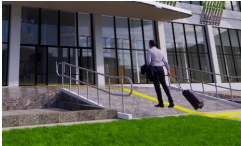
Gambar 16. Penggunaan Ramp dan Railing (Sumber: Analisis Penulis, 2023)
