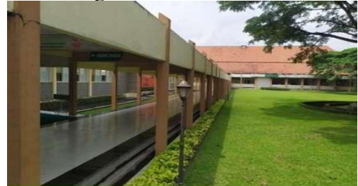
Gambar 16. Selasar Penghubung Inst. Gizi dan Instalasi Binatu/ Laundry (Sumber: Penulis, 2023)
