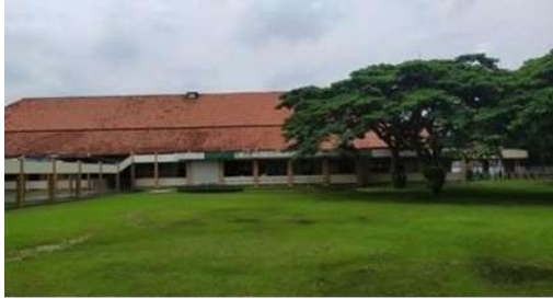
Gambar 13. Gedung Instalasi Gizi (Sumber: Penulis, 2023)
