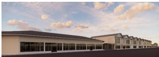
Gambar 9. Bangunan Utama (Sumber: Dokumen Pribadi, 2024)
