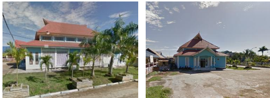
Gambar 2. Kondisi Bangunan Gedung Serba Guna Sebelum dialihfungsikan menjadi Kantor Mal Pelayanan Publik (Sumber: Penulis, 2025)
