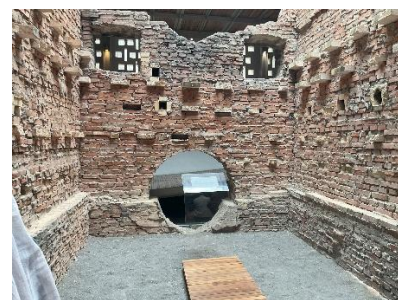
Gambar 16. Boiler room pabrik citronella (Sumber: dokumen pribadi, 2026)
