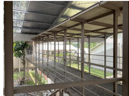
Gambar 28. Jembatan penghubung museum dan laboratorium (Sumber: dokumentasi pribadi, 2026)
